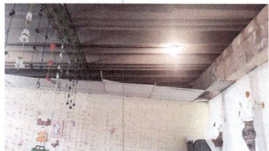
Foto 6:MODULO 3 sustitucion de lamina, por lamina troquelada aluzinc calibre 26 . Sustitucion de estructura de soporte de metal por metal.
