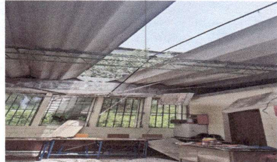
Foto 4: MODULO 1sustitucion de lamina, por lamina troquelada aluzinc calibre 26 . Sustitucion de estructura de soporte de metal por metal
