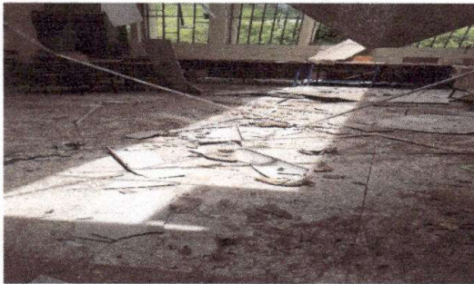
Foto 3: MODULO 1 sustitucion de lamina, por lamina troquelada aluzinc calibre 26 . Sustitucion de estructura de soporte de metal por metal
