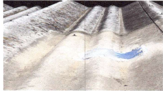
Foto 2: MODULO 1sustitucion de lamina, por lamina troquelada aluzinc calibre 26. Sustitucion de estructura de soporte de metal por metal
