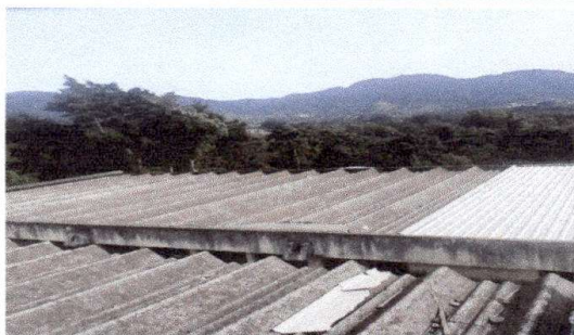
Foto 5: MODULO 2 sustitucion de lamina, por lamina troquelada aluzinc calibre 26. Sustitucion de estructura de soporte de metal por metal.
